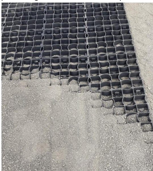
Mynd 2 Plastgrindur með möl sem undirlag og sand ofaná.
